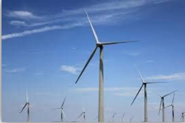
(圖2)風力發電機
